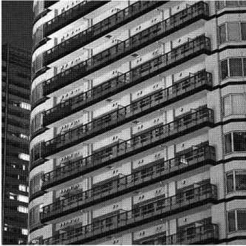
台風の被害で停電したタワーマンション(15日、川崎市中原区)
